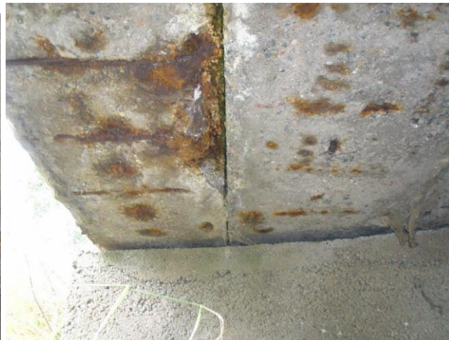
degradovaný beton ve spáře mezi nosníky s obnaženou výztuží
