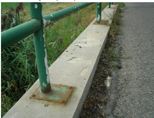
korozí patek zábradlí
