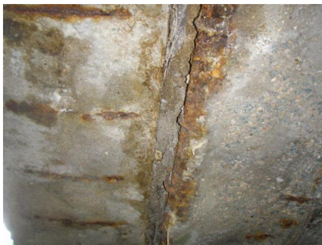
detail obnažené a zkorodované výztuže v pohledu NK
