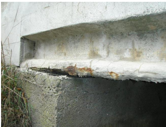
hloubkově degradovaný beton spodní hrany krajního nosníku s obnaženou výztuží
