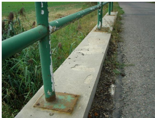
loupající se krycí vrstva na horní ploše římsy
