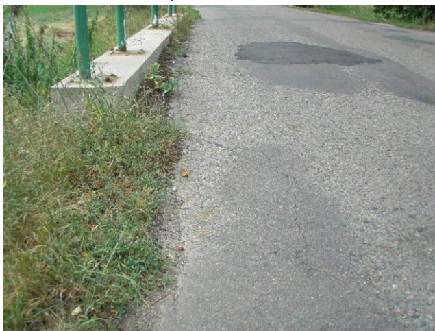
zakořeněná vegetace pod zvýšenou římsou
