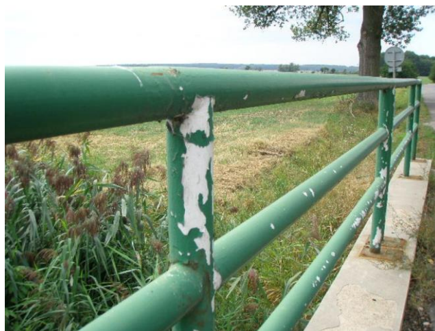
loupající se nátěr zábradlí
