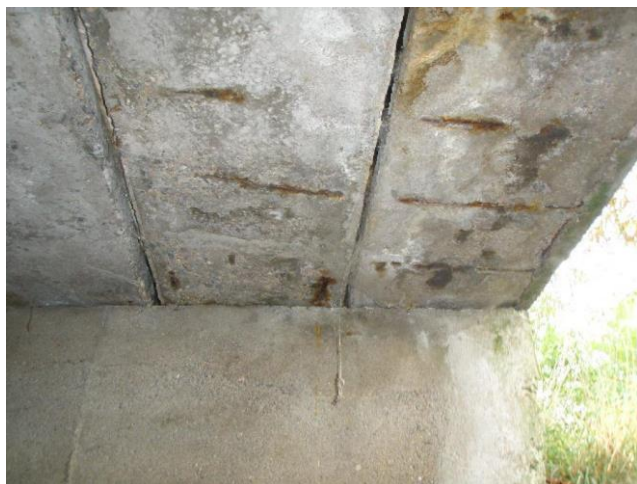
prorýsovaná korodující výztuž v pohledu krajních nosníků
