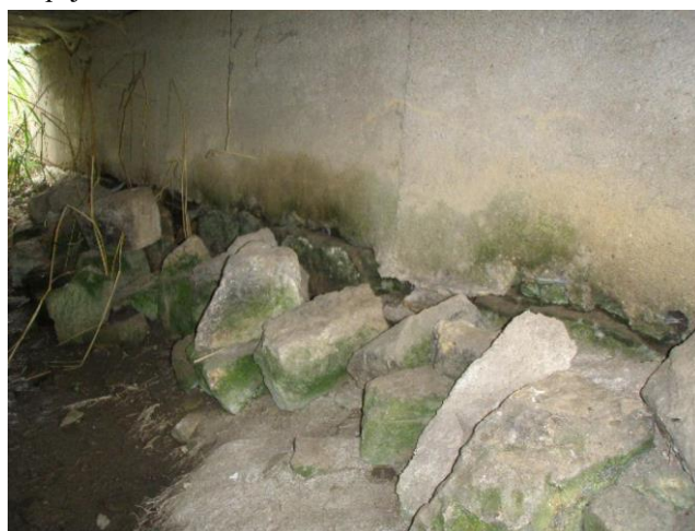
rozpadlé kamenné zpevnění koryta vodoteče
