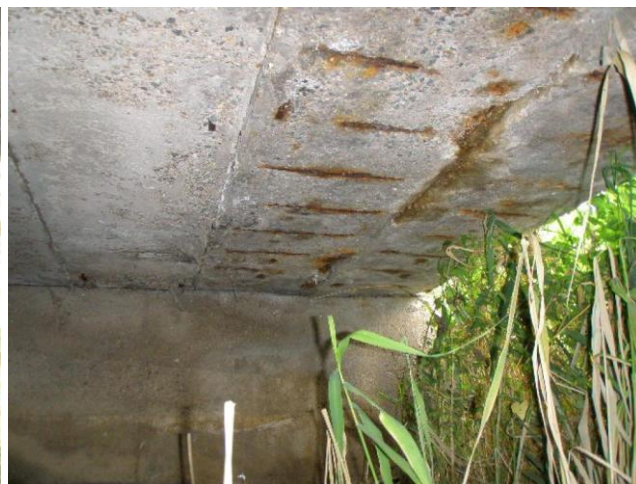
obnažená zkorodovaná výztuž na pohledu krajního nosníku
